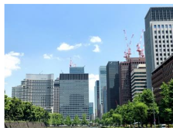
依然、高層ビル建設が進められている丸の内地区
