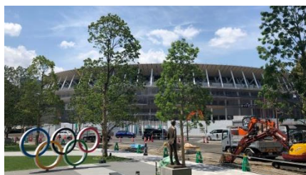
2020年に向けて建設が進む国立競技場
